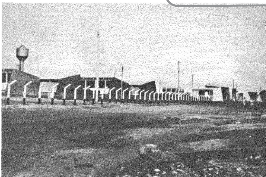
Imagem 9: Instalações de funcionários da petrobrás.
