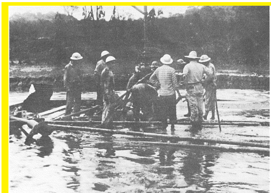
Imagem 7: Funcionários trabalhando na recuperação do AG-25,
